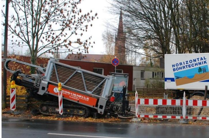
**Bohrgerät für Horizontalbohrungen**
